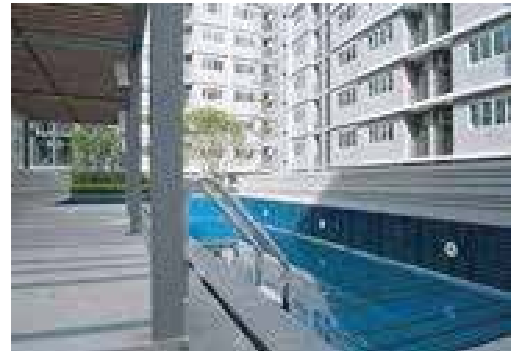
โปรเจ็ค ดีคอนโด อ่อนนุช จังหวัด กรุงเทพมหานคร
